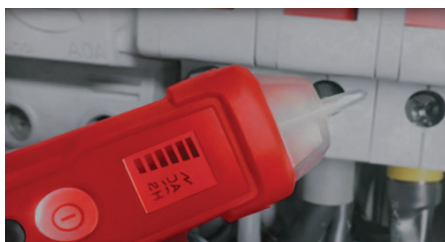
Vérification de la présence de tension sur prises, borniers, câbles et équipements
