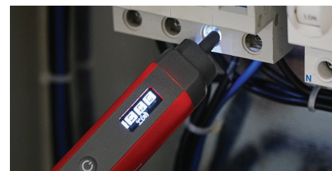
Indication de la rotation de phases (SEFRAM22)
