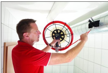
Abb. 6: Reinigung eines Lüftungsrohres
