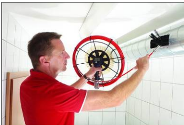
Imm. 36: Nettoyage d'un conduit d'air
