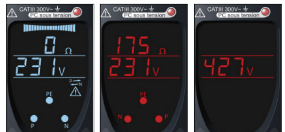
Prise mal câblée: phase présente sur PE
