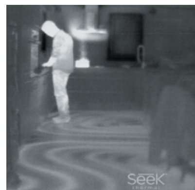
AUDIT CVC (EX. CHAUFFAGE AU SOL)
